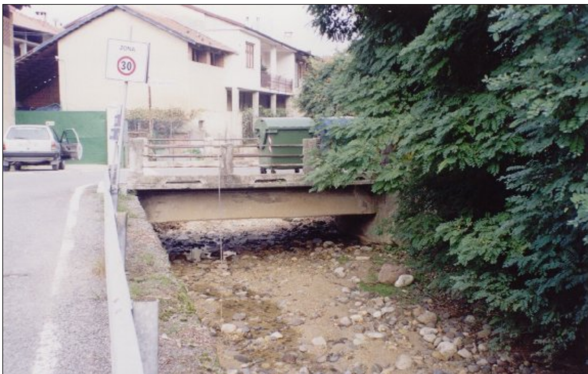
Foto n° 11 – Rio Secco ponte – opera n°13
