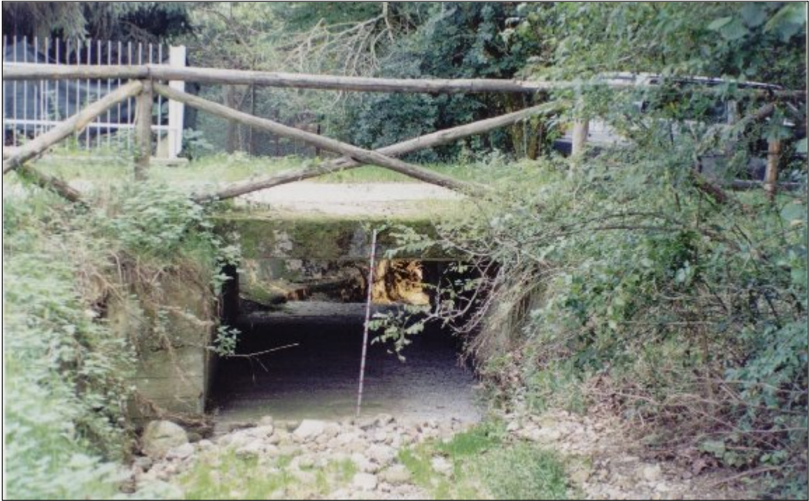
Foto n° 5 – Rio Verdeis attraversamento – opera n°6
