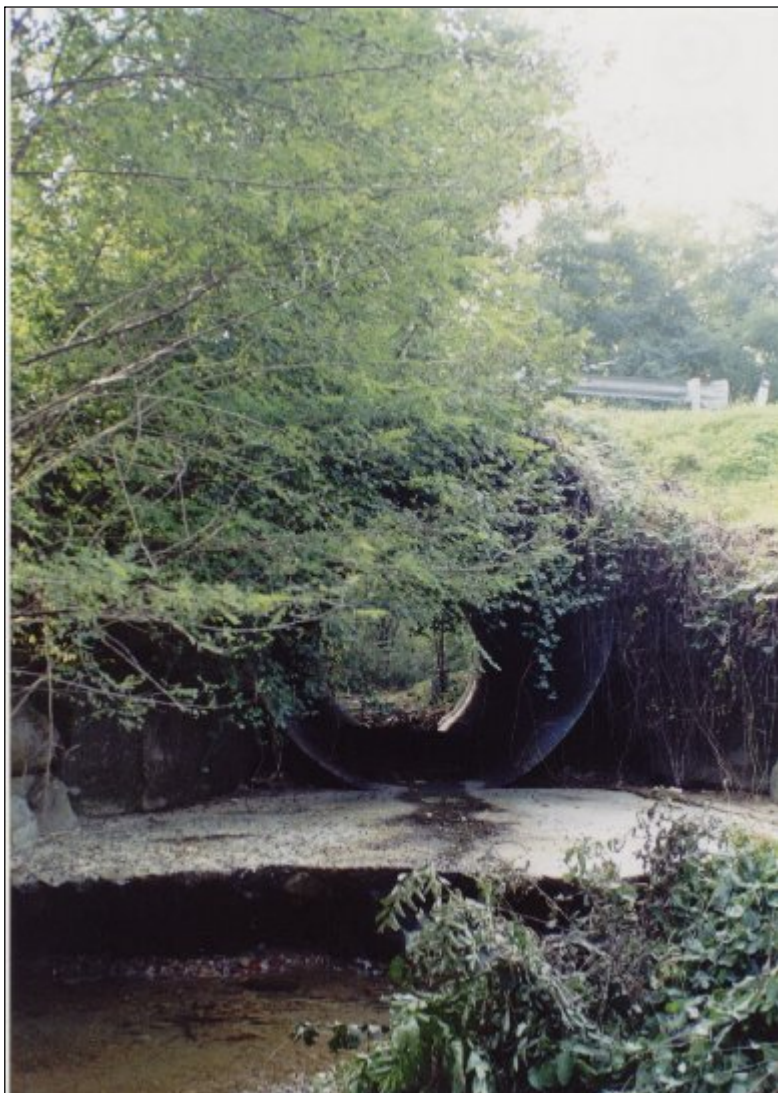
Foto n°3 – Rio Verdeis attraversamento - opera n°4
