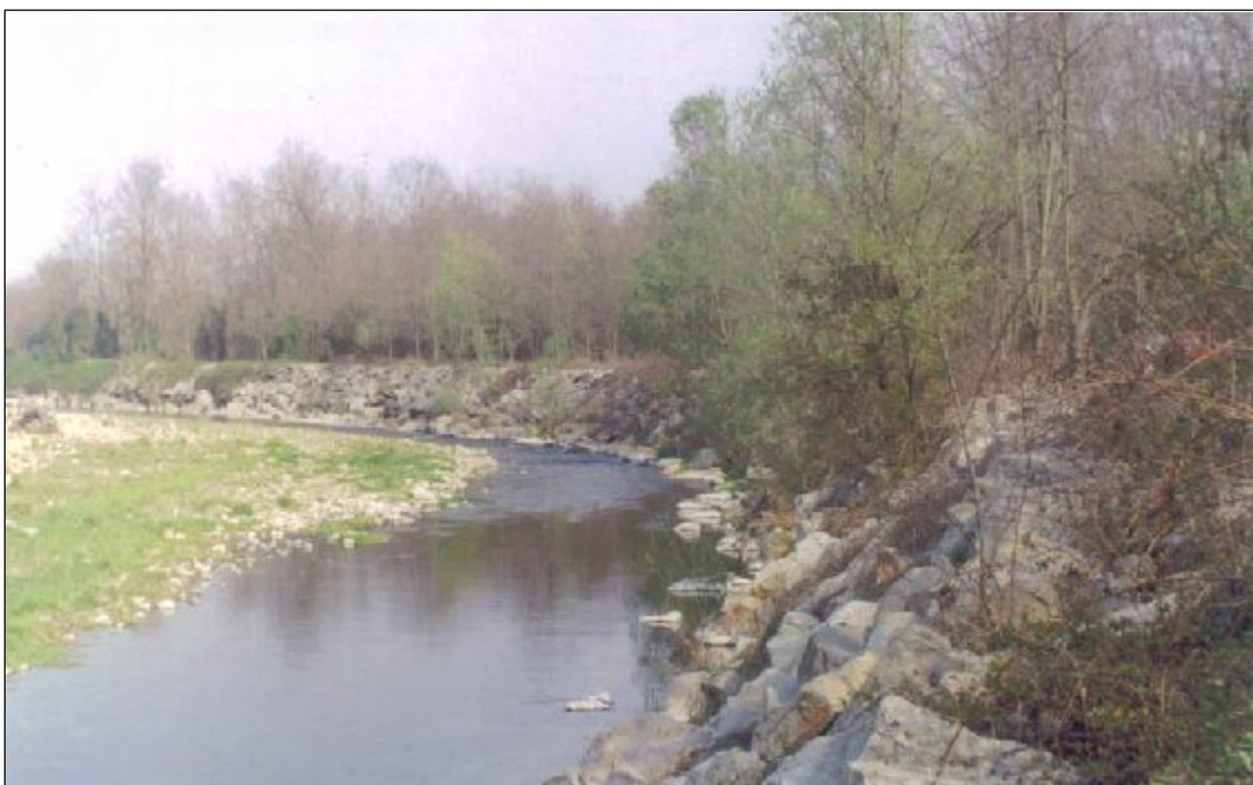
Foto n° 18 – Torrente Malone difesa spondale – opera n°29
