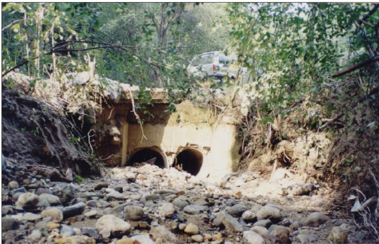
Foto n° 13 – Rio Secco attraversamento/tombatura – opera n°15
