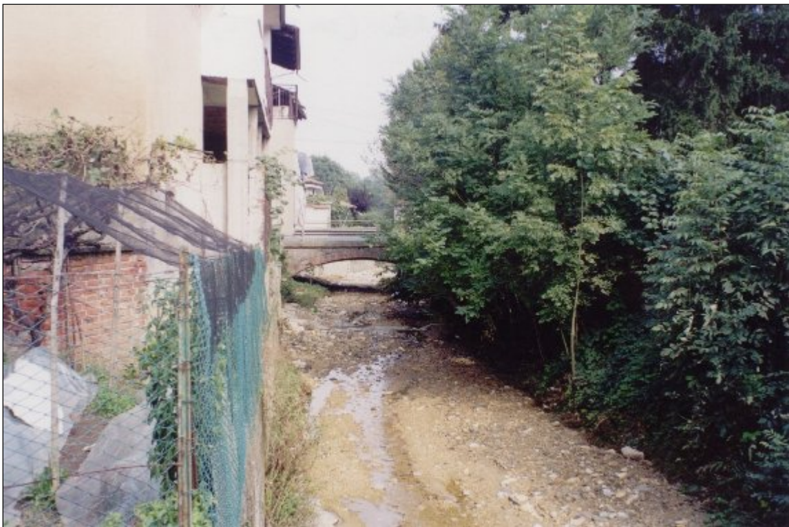
Foto n° 10 – Rio Secco ponte – opera n°12
