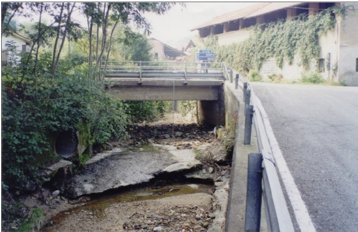
Foto n° 12 – Rio Secco ponte – opera n°14
