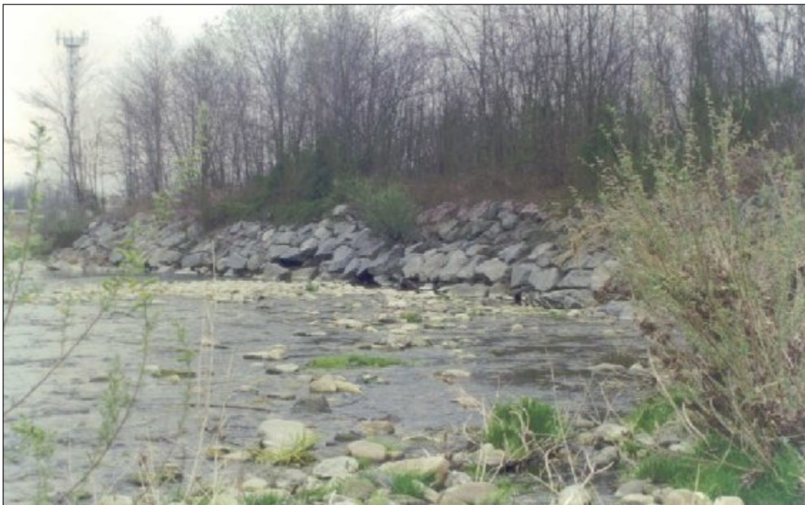
Foto n° 17 – Torrente Malone difesa spondale – opera n°25
