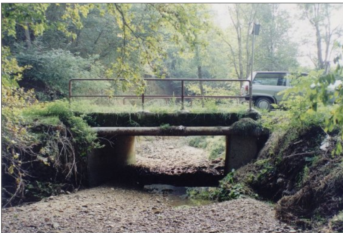
Foto n°4 – Rio Verdeis attraversamento- opera n°5
