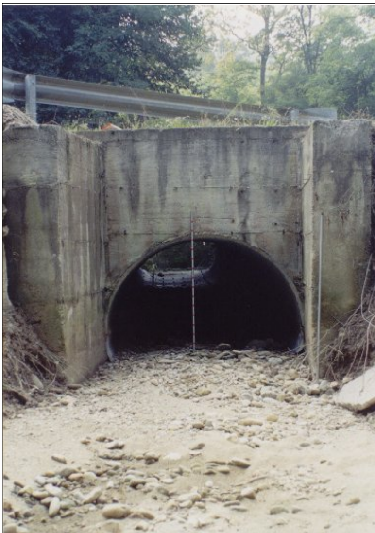
Foto n°7 – Tributario destro del T. Malone attraversamento- opera n°8
